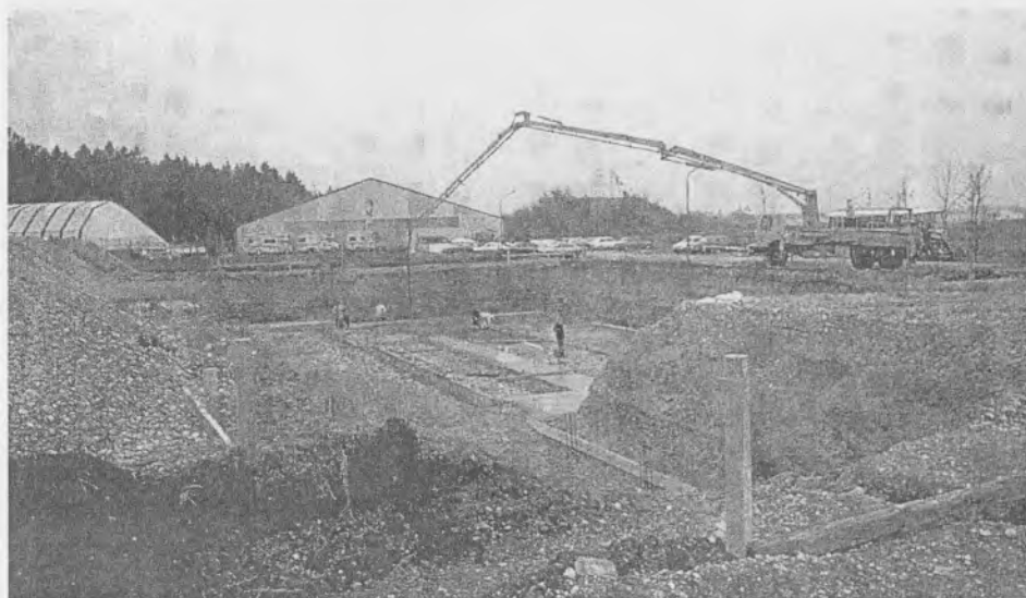
1982: Betonieren der Fundamente
