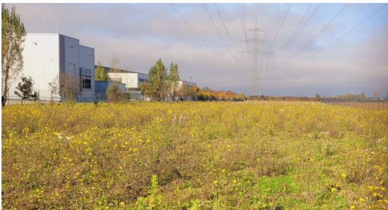
Abb. 4: zentraler Teil, Blick nach Norden
