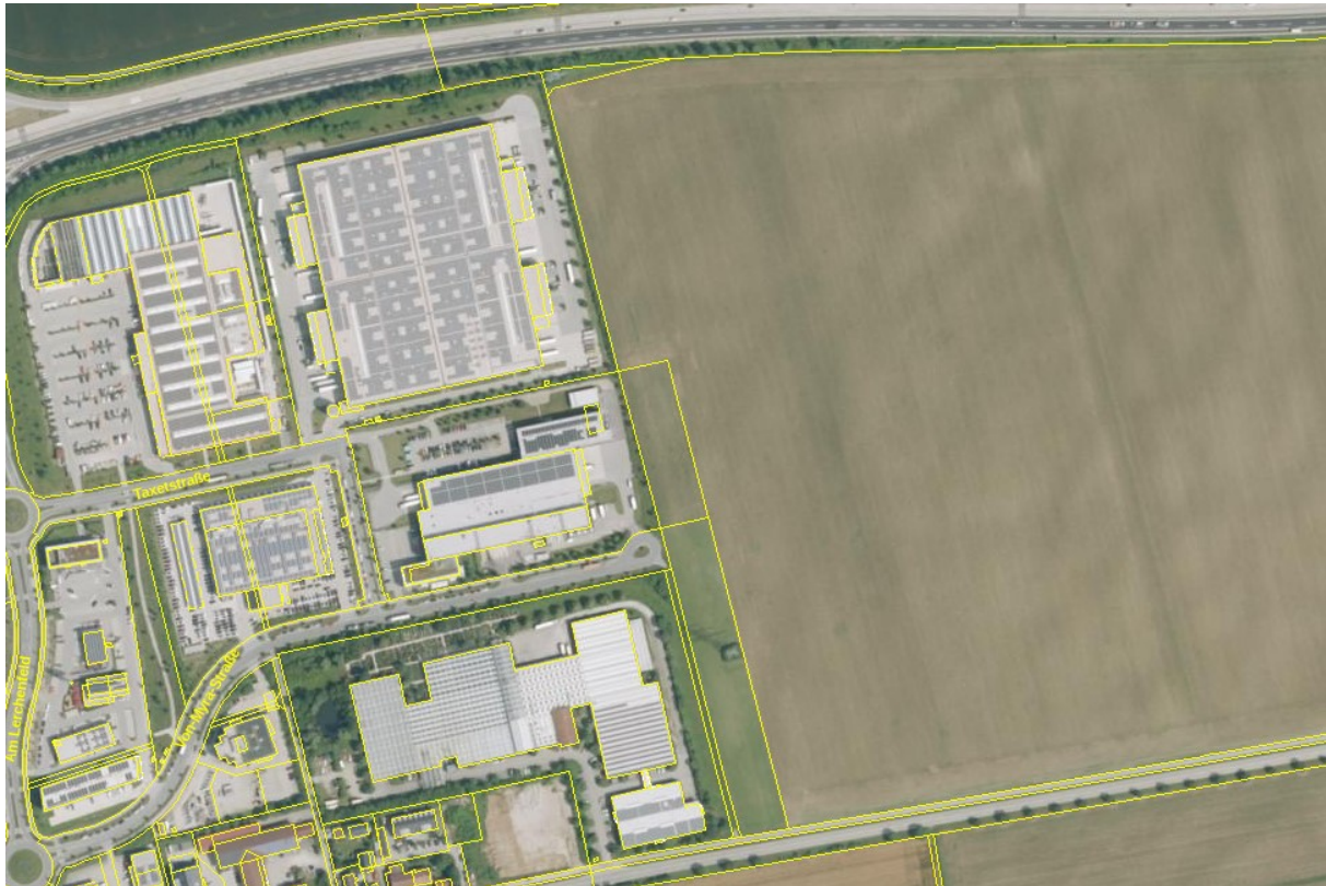
Abb. 3: Luftbild des Planungsbereiches
