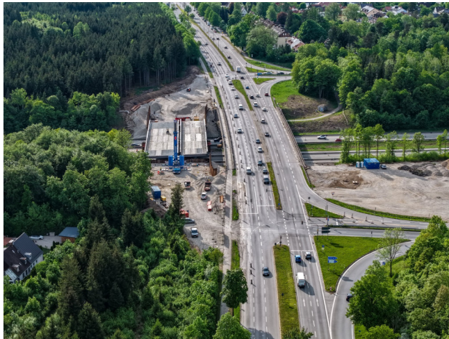
Bilder: Einhub und Fertigstellung des Einhubs der Behelfsbrücke © Autobahn Südbayern/ Felix Bonn
