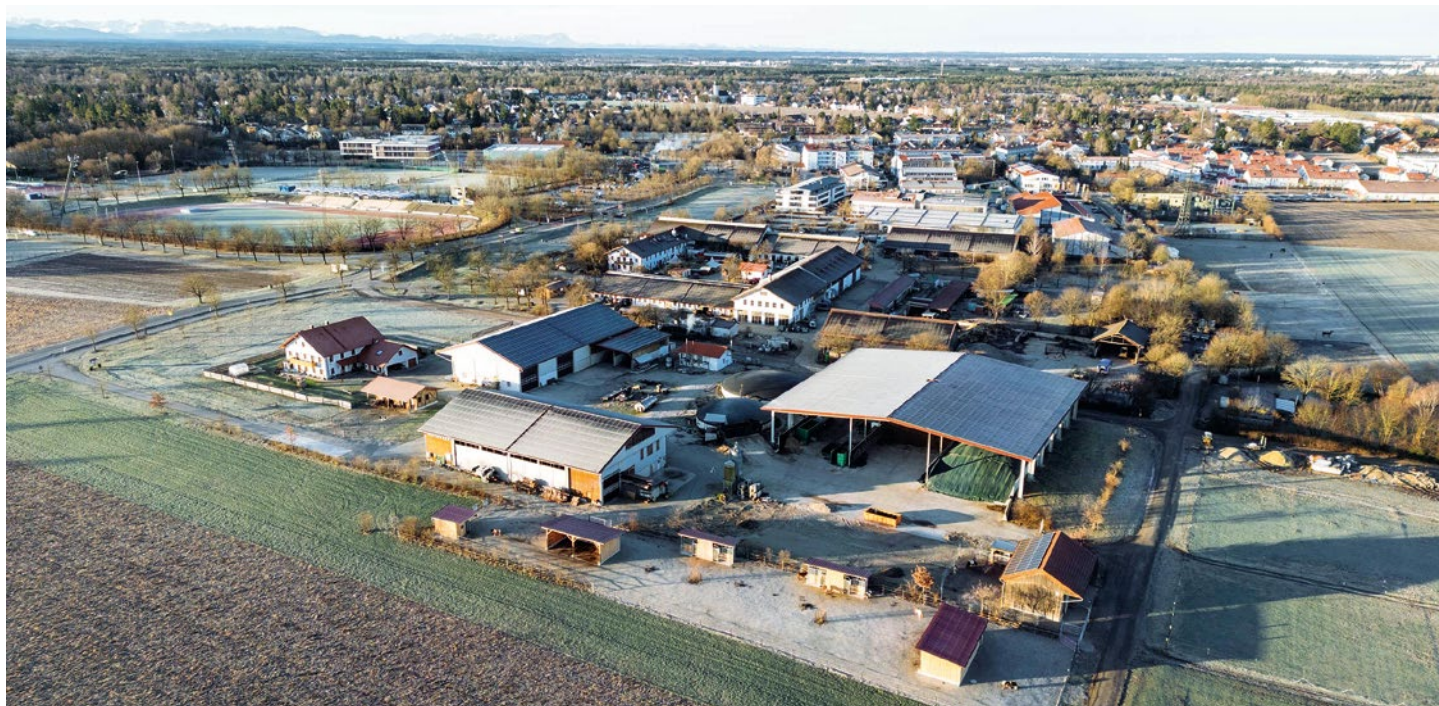
Biogasanlage Böhm am Ortsrand von Vaterstetten.
