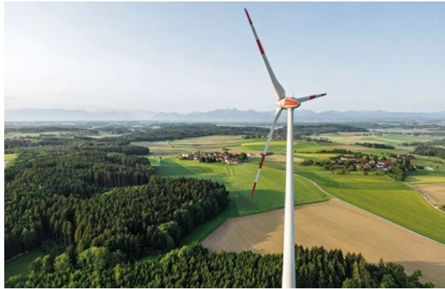
Das erste und bisher einzige Windrad im Landkreis Ebersberg in Hamberg, Gemeinde Bruck.
