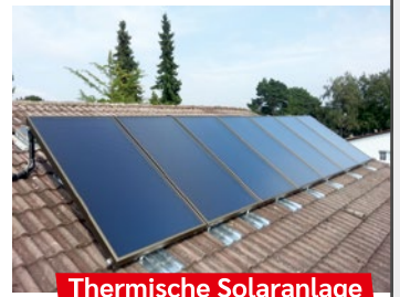
Thermische Solaranlage
