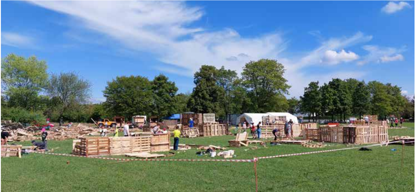
Es wird gehämmert, gesägt, gewerkelt – die ersten Grundgerüste stehen.
