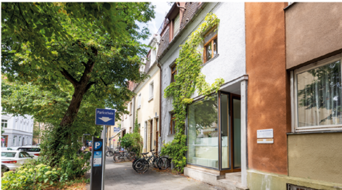
M-Nymphenburg: Mehrfamilienhaus mit vier Einheiten, gesamt ca. 270 m 2 Fläche KP: € 2.950.000
